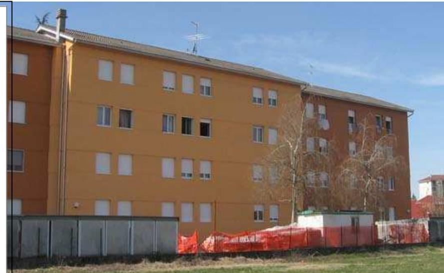
**Fabbisogno energia termica per riscaldamento : da 230 kWh/m2a a 120 kWh/m2a**
